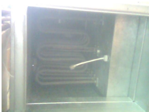
Рисунок 3 – Електронагівач повітря (ТЕН) з аварійними датчиками температури та датчиком температури повітря в каналі
