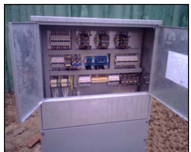
ШАФА ВУЛИЧНОГО ОСВІТЛЕННЯ (м. Бровари)
