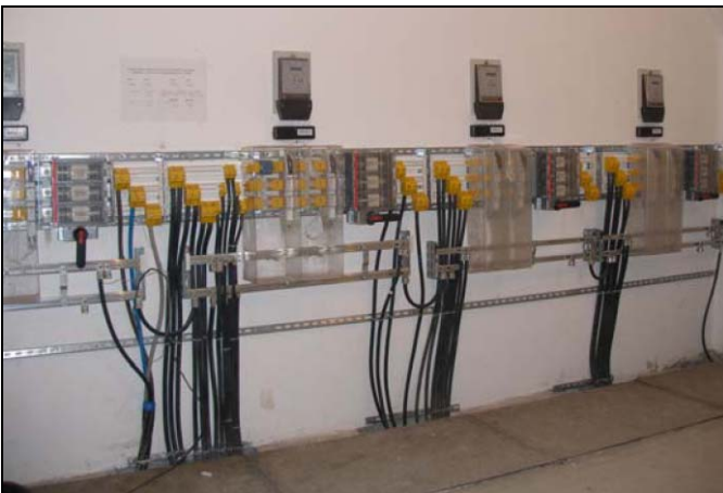
РП-0,4 СІЛЬСЬКОЇ ТРАНСФОРМАТОРНОЇ ПІДСТАНЦІЇ (Житомирська обл.)
