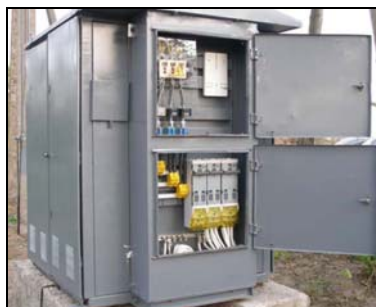
РП-0,4 СІЛЬСЬКОЇ ТРАНСФОРМАТОРНОЇ ПІДСТАНЦІЇ (Житомирська обл.)
