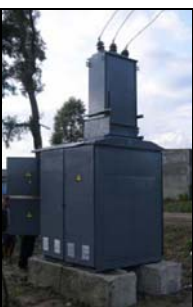
РП-0,4 СІЛЬСЬКОЇ ТРАНСФОРМАТОРНОЇ ПІДСТАНЦІЇ (Житомирська обл.)
